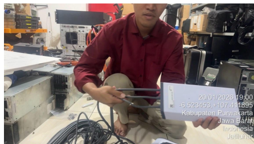
Gambar 4.11. Pemasangan kabel power Sumber: Penelitian
