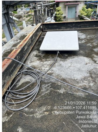
Gambar 4.9. Penempatan antenna KIT Sumber: Penelitian
