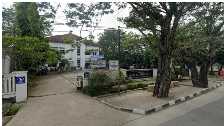
Gambar 1 Kantor Kecamatan Karawang Barat
